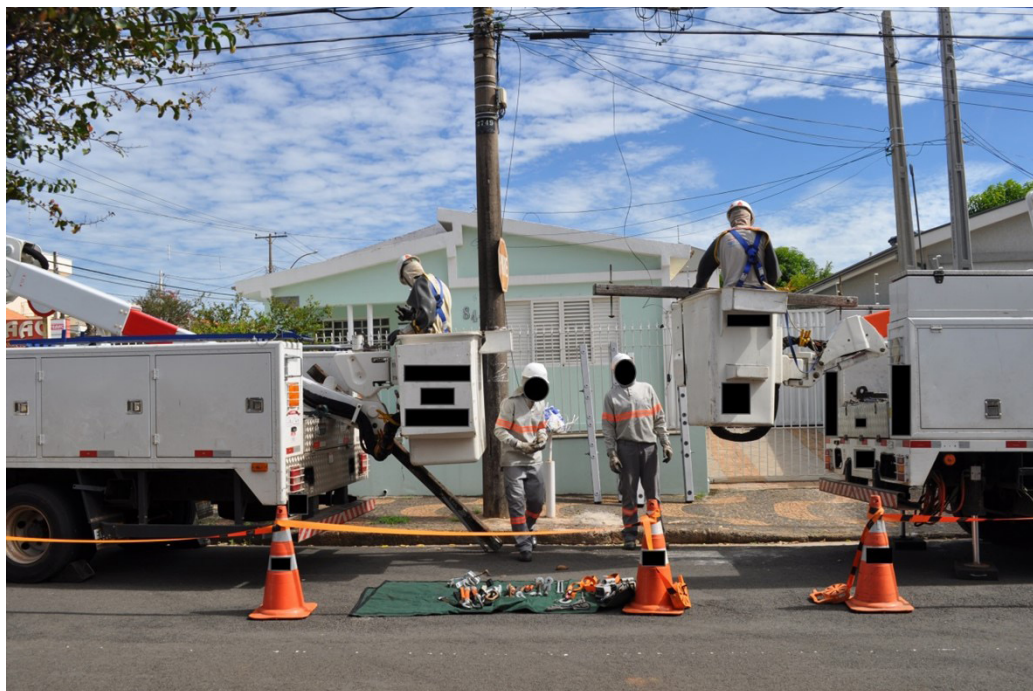
Figura 1. Troca de cruzetas em rede de distribuição em via pública – Atuação duas equipes de linha viva. Fonte: Base de dados dos autores.
